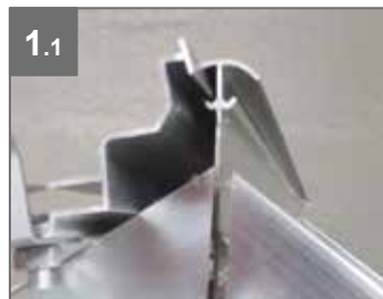
1.1 Anbringung des Fensters auf First durch Gleiten
